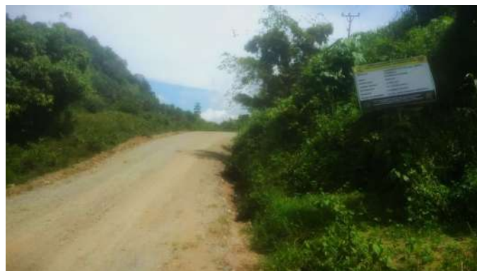
Proyek peningkatan jalan Bualemo-Timbuale, Kecamatan Kwandang
